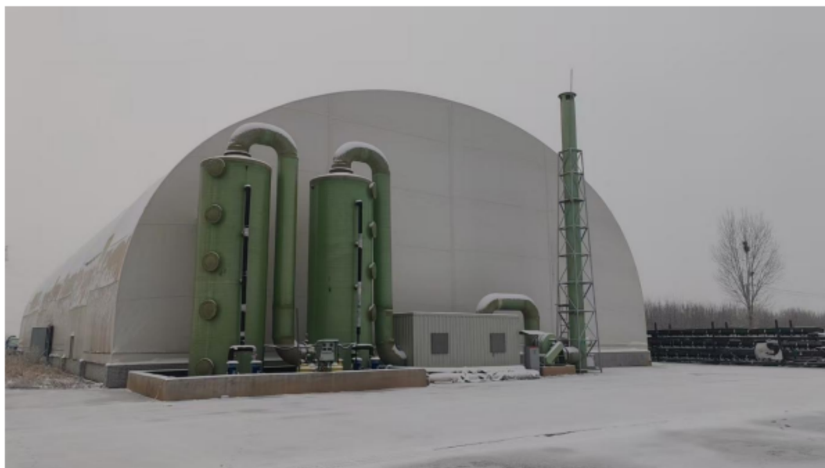
生活垃圾筛分综合处理厂房及废气治理设施
