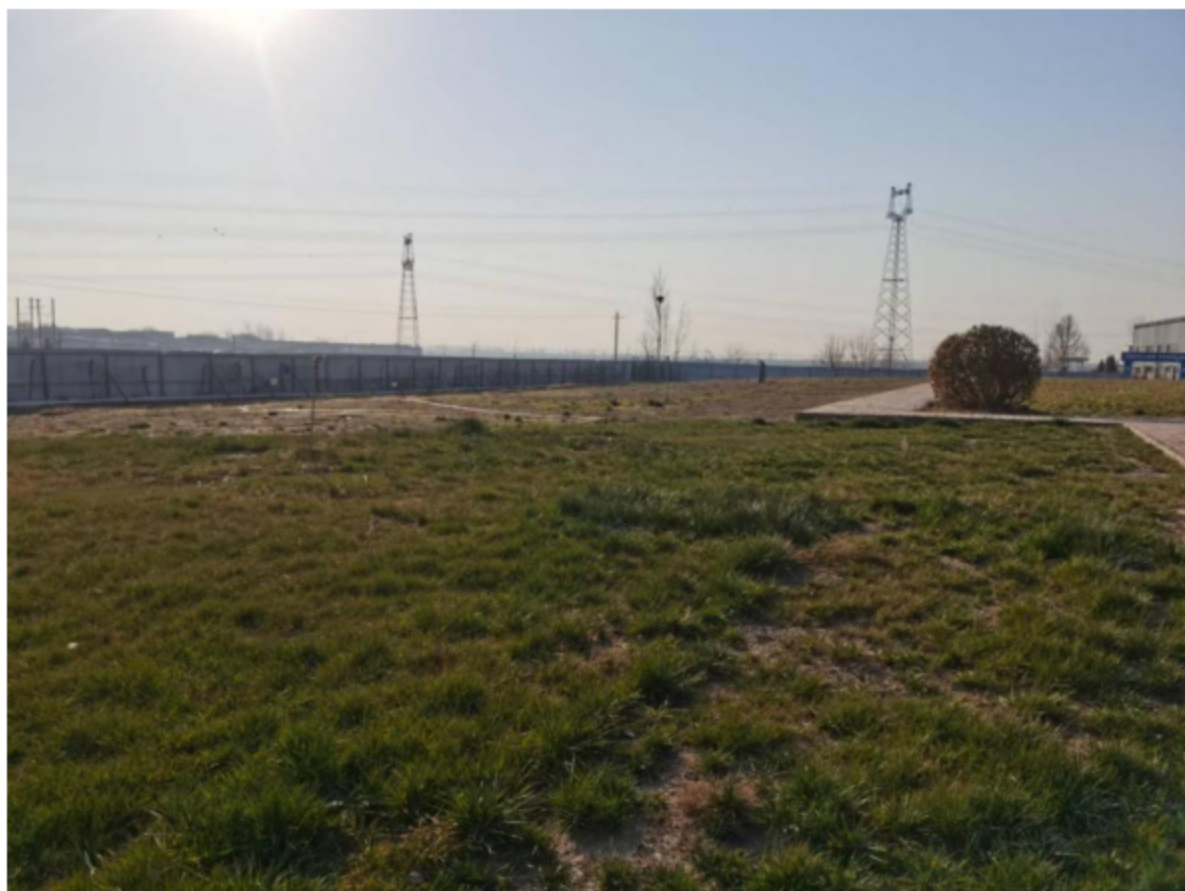
填埋场封场现状
