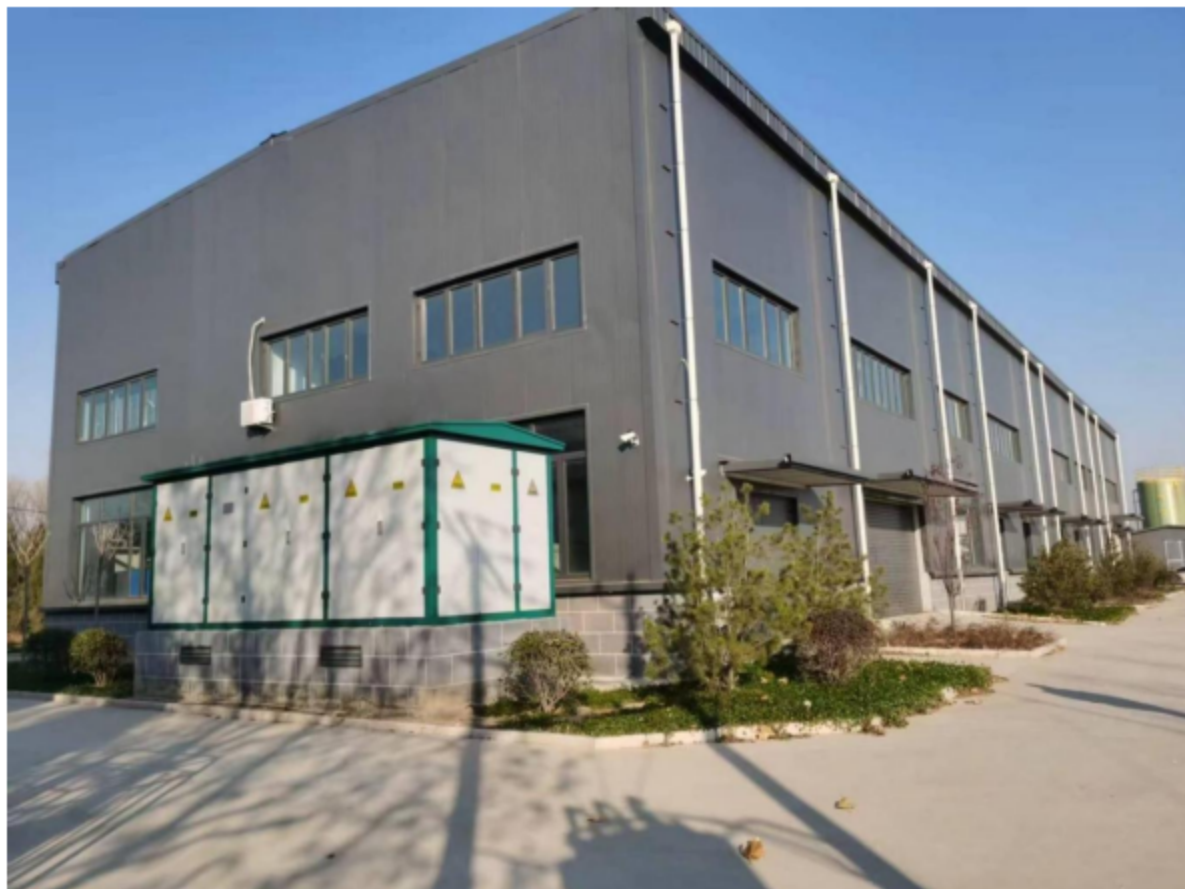
餐厨垃圾处理车间
