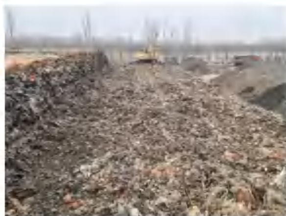
陈腐垃圾开挖
