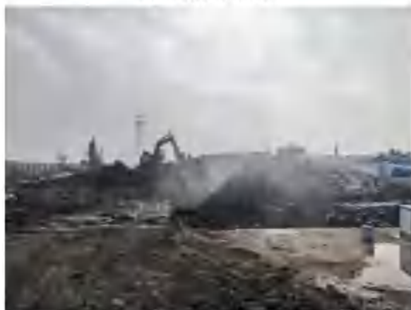
陈腐垃圾开挖
